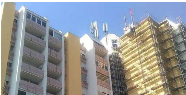
Višestambena zgrada Sjenjak 101, Osijek
